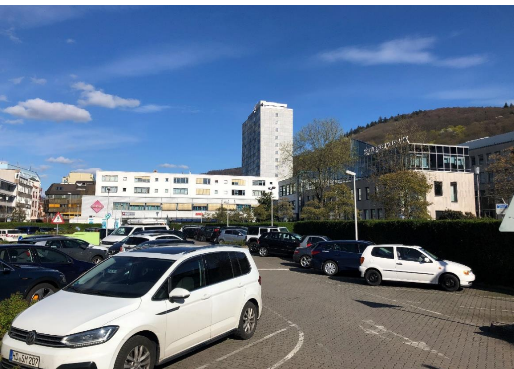
Abbildung oben: Gebäude der Sparkasse Blick von Poststraße
