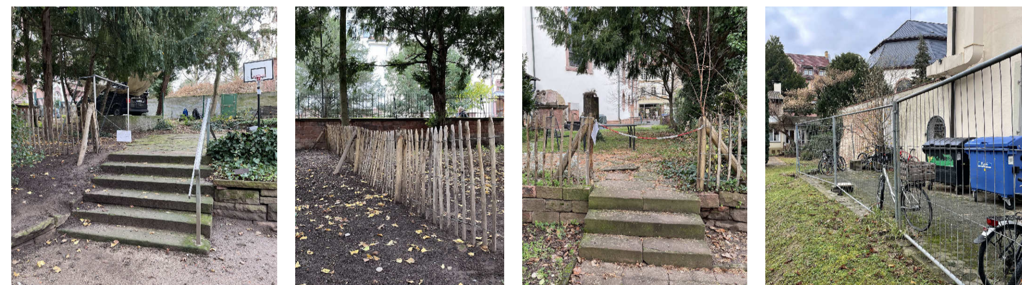
3.1 Übergang Stellplätze Gemeindehaus 3.2 Zaun Stellplatzbereich 3.3 Übergang Providenzkirche 3.4 Übergang / Zugang Innenhof Friedrichstr.
