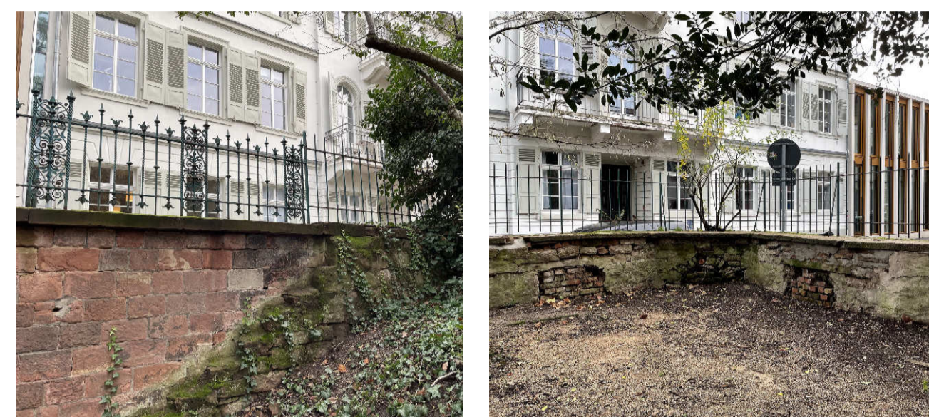
2.1 ornamentaler Stabgitterzaun (Friedrichstraße) 2.2 schlichter Stabgitterzaun (Landfriedstraße)
