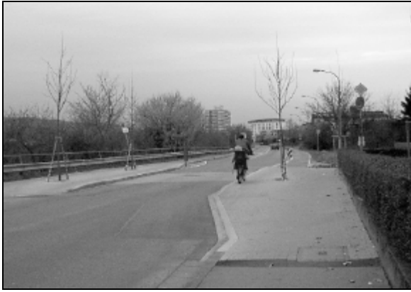
Torsituation am südlichen Stadteingang
