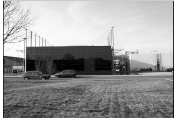
Neubau der weltbekannten Firma Lamy, Grenzhöfer Weg
