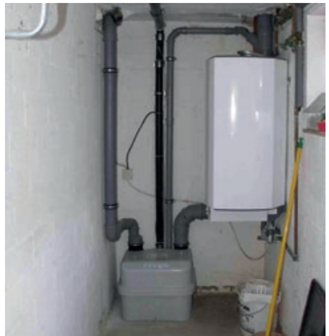
44 Hebeanlage
