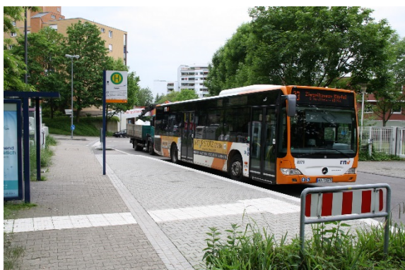
Ausgebauter Haltestellenbereich Forum
