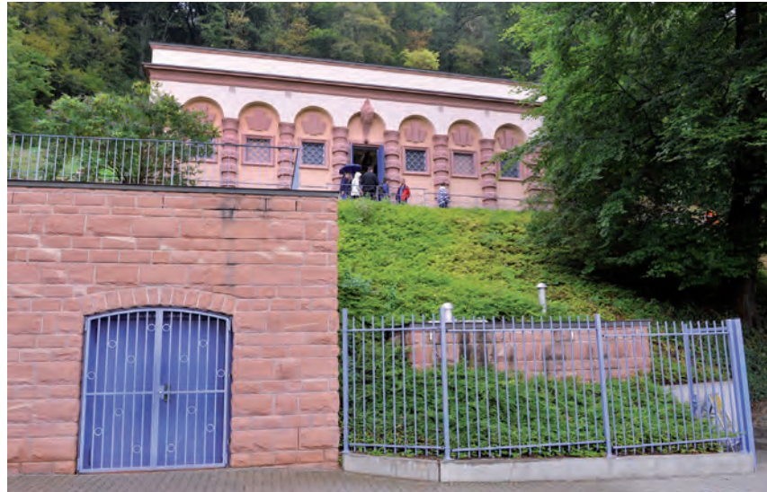
Am bundesweiten Denkmaltag öffnen die Stadtwerke Heidelberg den Eselsgrundbehälter.
