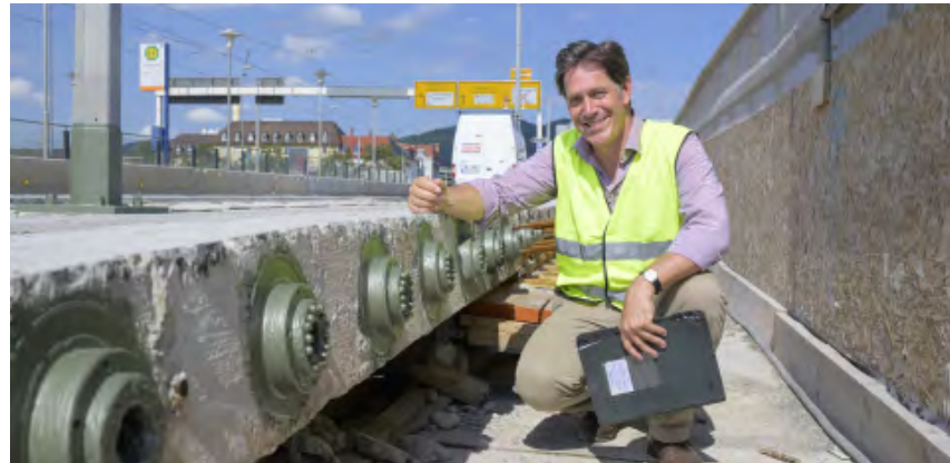
EBM Jürgen Odszuck begutachtete den Stand der Arbeiten an der Montpellierbrücke. Bisher wurden rund 3.000 Quadratmeter der Betonfläche instandgesetzt. (Foto Rothe)
