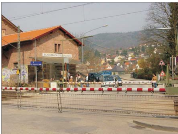
Beschränkter Bahnübergang am Bahnhof Schlierbach
