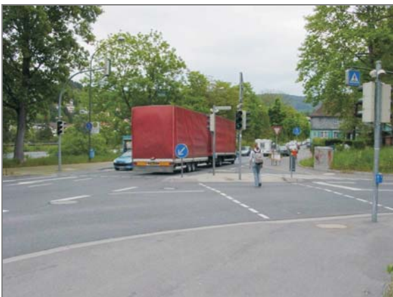
Fußgängerüberweg B 37 Höhe Wolfsbrunnensteige
