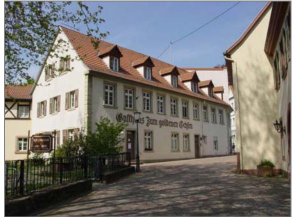
Seniorenzentrum Ziegelhausen in der Brahmstrasse 6
