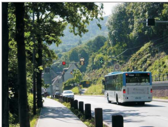
ÖPNV Spur, Schlierbacher Landstraße
