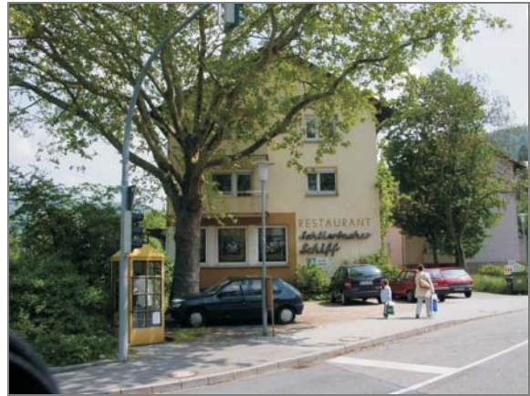
Ehemaliges Restaurant „Schlierbacher Schiff“
