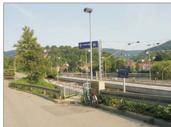
Fußgängerunterführung am Bahnhof Schlierbach
