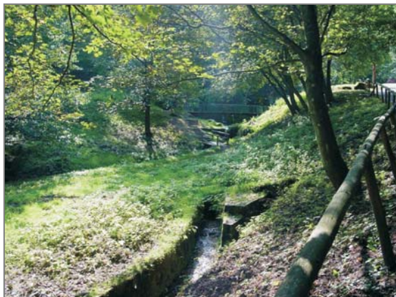
Schlierbach entdolt, Wolfsbrunnenanlage
