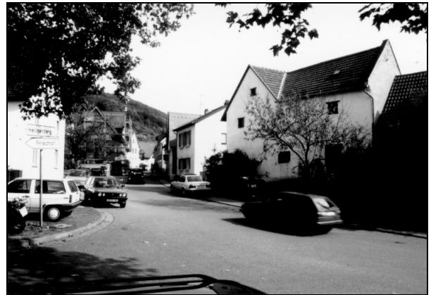
Gestaltungsdefizite in der Mühlthalstraße (ehem. "Mutschler's Eck")
