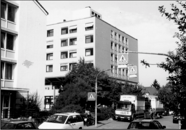
Markante Orientierung: Salem-Krankenhaus
