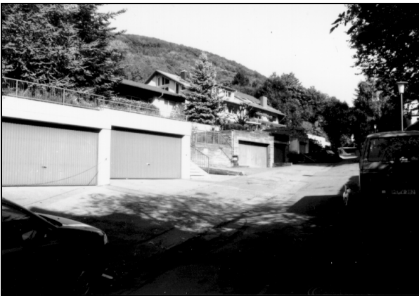
Gestaltungsdefizite in der oberen Mühlthalstraße: Garagen, versiegelte Vorplätze ohne Abgrenzung zum Straßenraum
