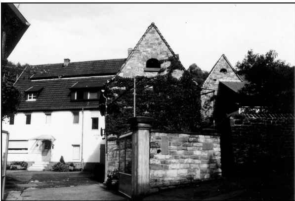
Ehemalige 3. Mühle im Mühlbachtal
