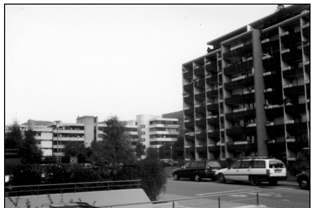
Fritz-Frey-Straße, Handschuhsheim-Nord Gute Orientierung mit erheblichen Gestaltungsdefiziten
