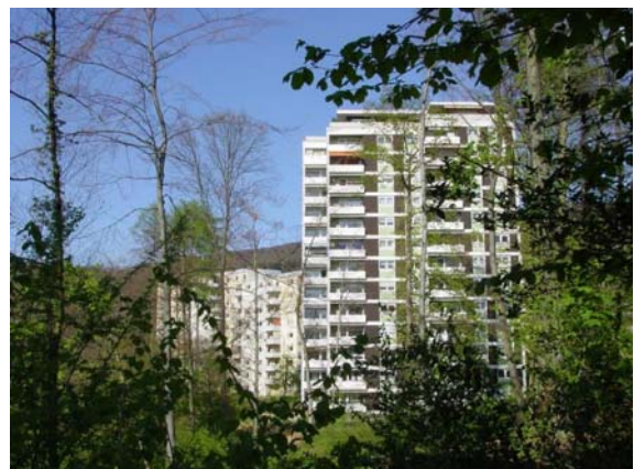
Punkthäuser im Norden, Zur Forstquelle 10
