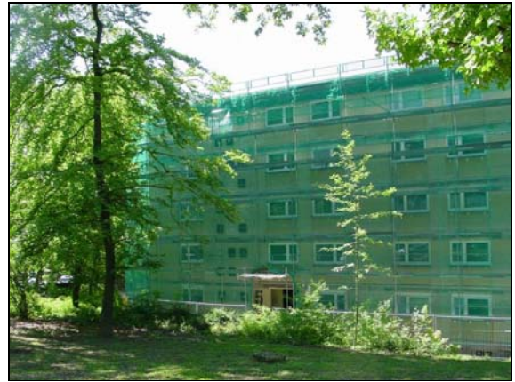
Energetische Modernisierungsmaßnahmen „Im Eichwald 1-5“
