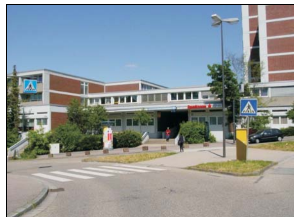
Südlicher Zugang zum Einkaufszentrum
