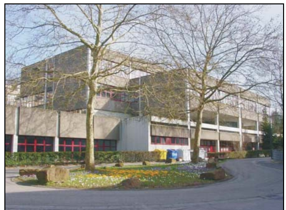
Hotelfachschule von der Straße „Am Ebertsrott“
