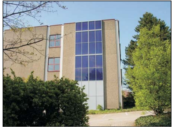
Thermische Solaranlage an der Südfassade der Hotelfachschule
