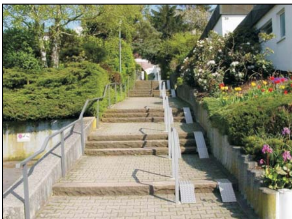
Treppenanlage zwischen Berghalde und Boxbergring
