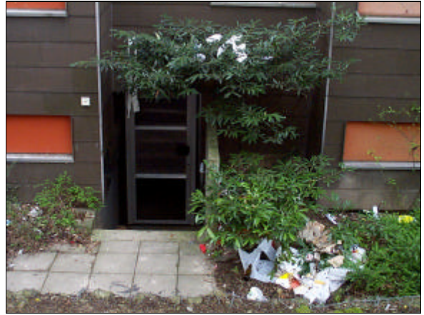
Rückwertiger Notausgang: Hier als Müllkippe missbraucht
