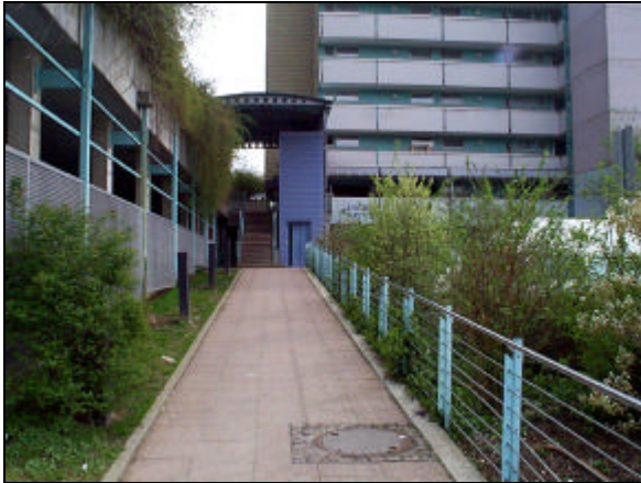
Westliche Öffnung der Garagenanlage zur besseren natürlichen Beleuchtung
