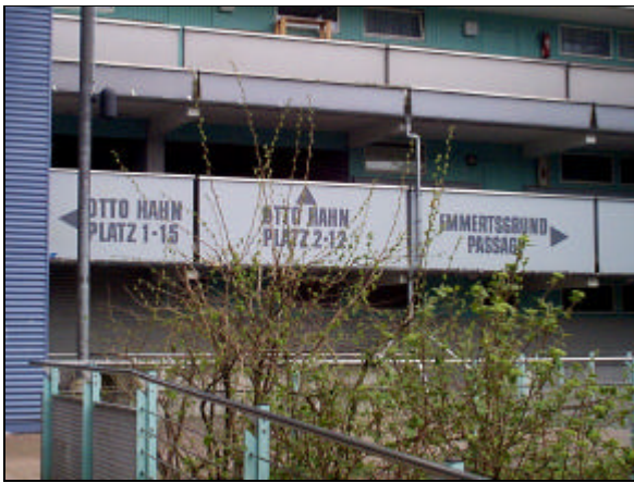
Neue Orientierungshilfen - Bereich Otto-Hahn-Platz
