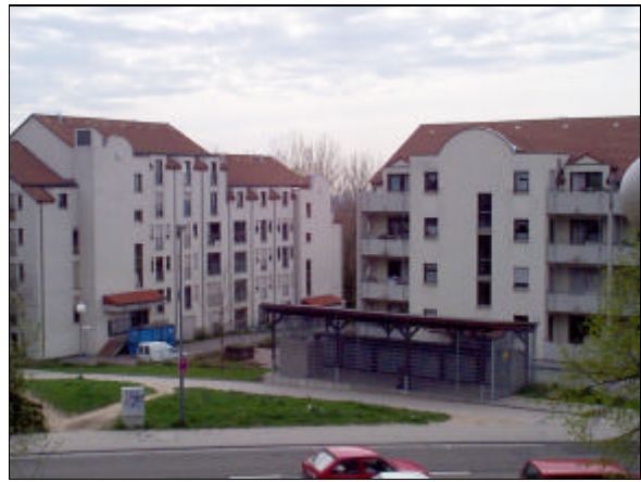
Gebäude am Botheplatz 86-88
