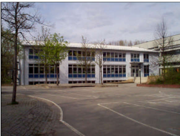
Erweiterungsbau der Emmertsgrundschule
