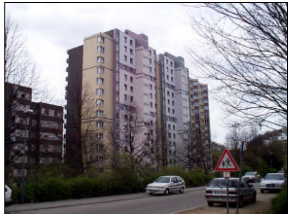
Emmertsgrundpassage 1-7: Beispiel für eine ansprechende Fassadengestaltung - östliche Ansicht
