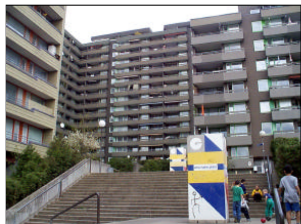
Massive Hochhausbebauung im nördlichen Teil des Emmertsgrundes
