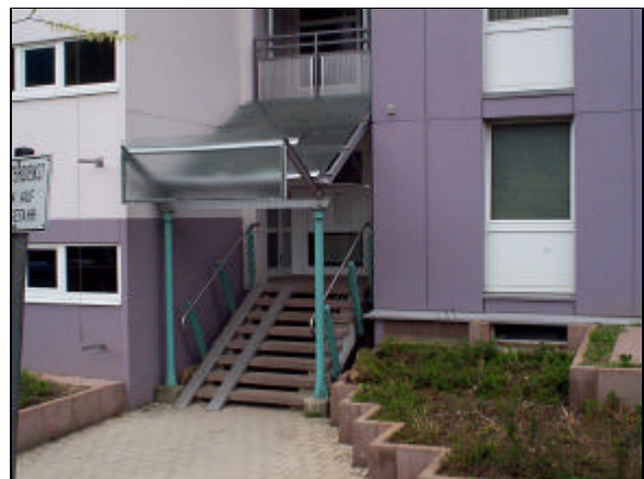
Emmertsgrundpassage 1-7: Neu gestaltete Eingänge - östliche Ansicht
