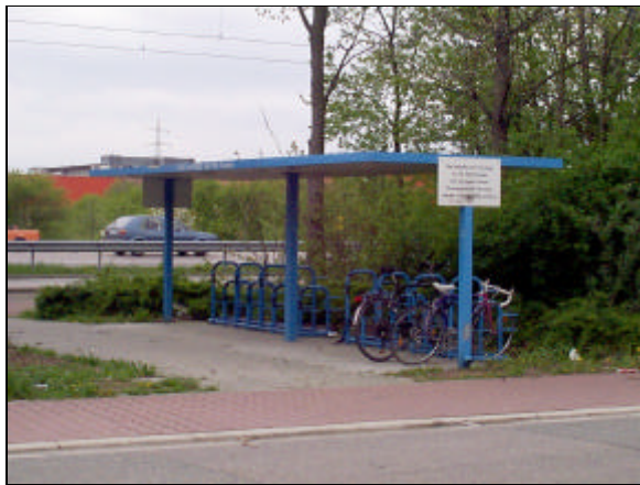
B+P-Anlage bei der Haltestelle Rohrbach-Süd
