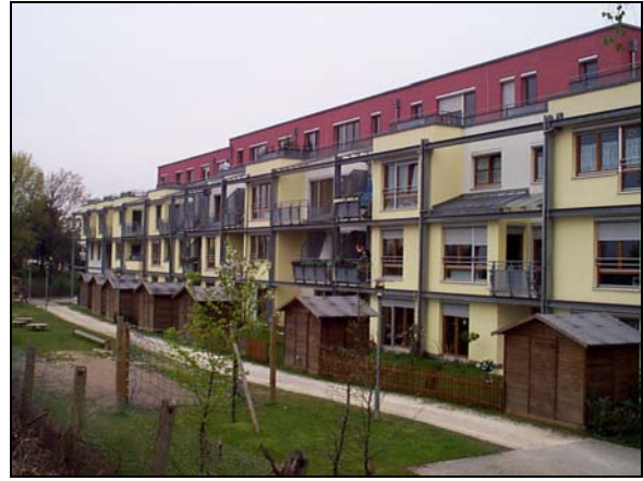
Wohnanlage in der Philipp-Reis-Straße (ehemalige Stadtgärtnerei)
