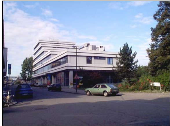
Ehemaliges Postgebäude, heute von der Heidelberger Druckmaschinen AG genutzt
