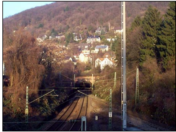
Eingang Königstuhltunnel nördlich des Bergfriedhofs
