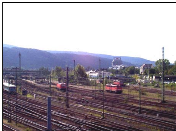
Gleisanlagen im Bahnhofsareal
