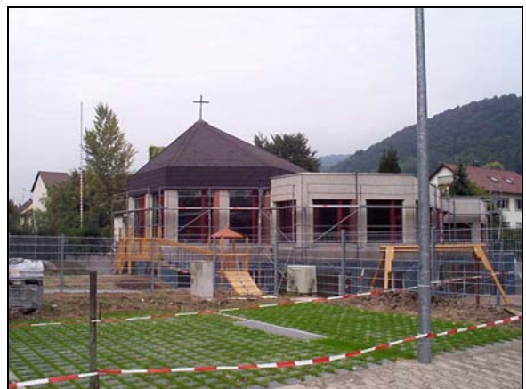
Markushaus im Umbau
