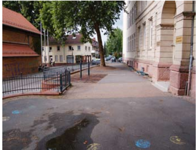
Westliche Freifläche der Eichendorffschule (frühere Heidelberger Straße)
