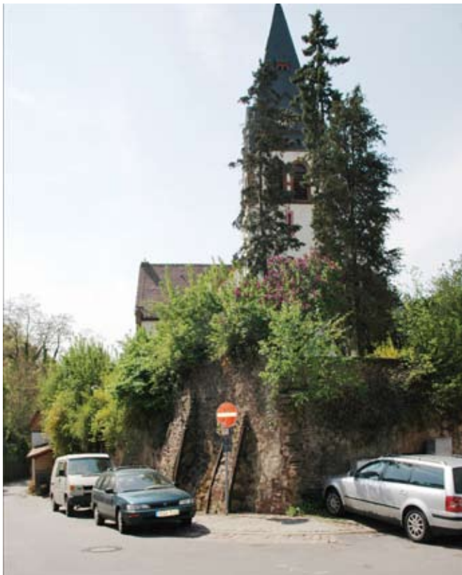
Stützmauer der Melancthon-Kirche
