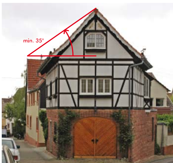
Minimale Dachneigung im Vergleich zum Dach im Bestand Am Heiligenhaus 11/1
