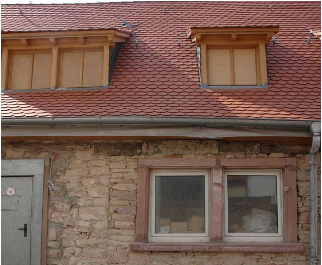
Dachrinne aus Zinkblech, Rathausstraße 5
