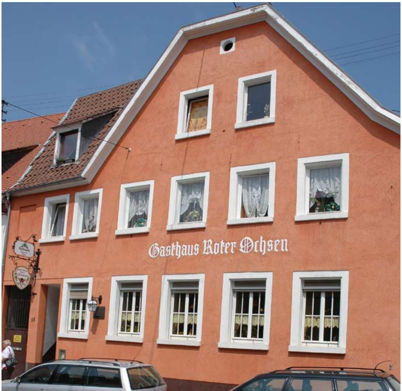
Werbeanlagen müssen sich in die Gestaltung des Gebäudes einfügen, Roter Ochsen, Rathausstraße 55
