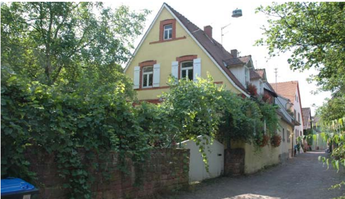
Begrünung von Einfriedung und Fassade, Junkergasse 8
