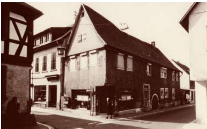
Freilegung historischen Fachwerks, Sanierungsbeispiel
