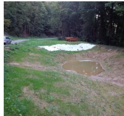
Rahmen einer weiteren Ausgleichsmaßnahme verwendet. Durch den Ingenieurweg befindet sich dort noch stark durchlässiges Schuttmaterial. Dies stellte an die Umsetzung besondere Ansprüche. Über die Zuführung von Oberflächenwasser direkt vom Ingenieurweg und von anderen Wegen, wie dem Alten Linsenteichweg durch eine Wasserableitung soll das Biotop mit ausreichendem Wasser versorgt werden. Nördlich grenzt eine Feuchtwiese an das Biotop.
