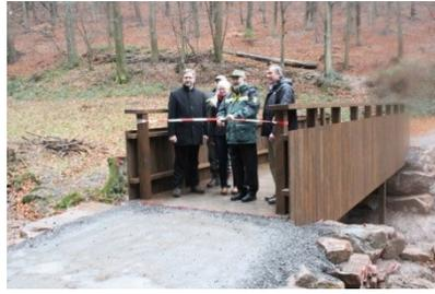
Das Bauwerk ist im Hinblick auf die Anforderungen an die Verkehrssicherheit, die auch im Wald gestiegen sind, gestaltet: Die Brücke ist zwei Meter breit und das Geländer ist 1,30 Meter hoch, so dass sie von Fahrradfahrern im Gegenverkehr passiert werden kann. Zudem ist das Tragegewicht so ausgelegt, dass auch Reiter mit Pferd die Brücke passieren können. Damit werden aktuelle Ansprüche an die auch im Wald gestiegene Verkehrssicherheit umgesetzt.
